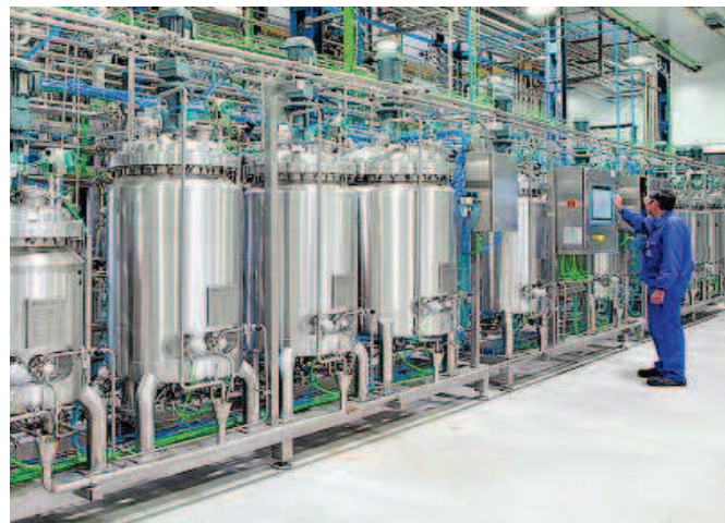
Un operario de ADL trabajando en una de las instalaciones. :: ADL
