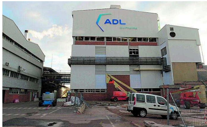
ADL Biopharma obtuvo un préstamo para modernizar sus instalaciones. :: L.N.C.
